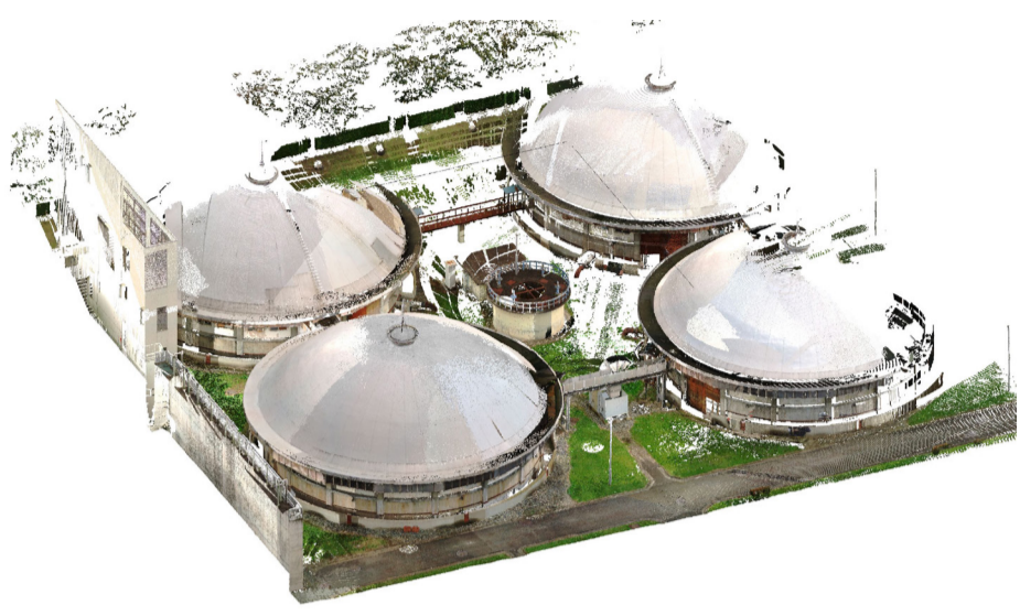
設計図のない施設の撤去にあたり、点群+ドローンにより撮影
