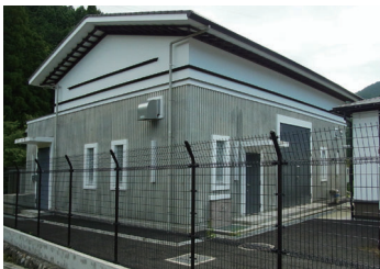
開口部分には門型の増打ちを行った。
