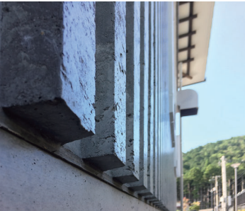
腰壁部分は化粧型枠によりリブを設けた。
