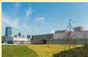
放流ポンプ棟(左) 管理連(右)
